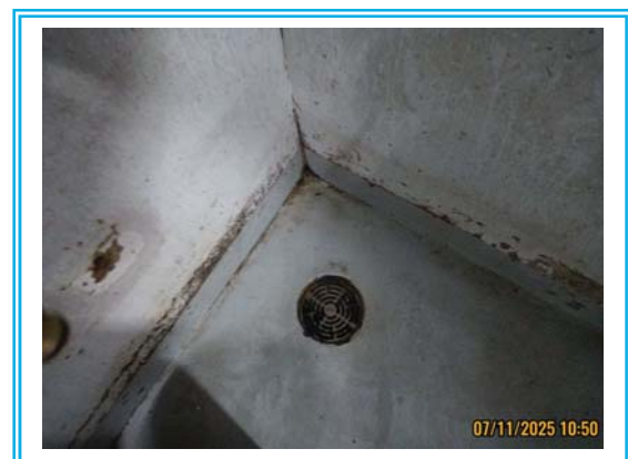
รูปที่ 3-32 ท่อรวมน้ำจากการล้างพื้นห้องพักขยะ
