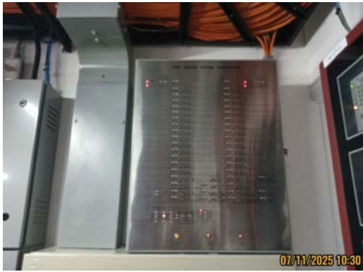
รูปที่ 3-55 แผงควบคุม (Fire Alarm Control Panel : FCP)
