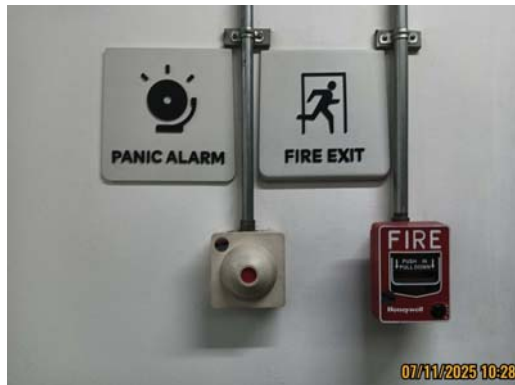
รูปที่ 3-57 เครื่องแจ้งเหตุโดยใช่มือติ่ง และกริ่งสัญญาณเตือนอัคคีภัย
